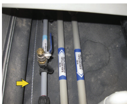
-Figuur 5- Deze leidingen zijn beveiligd met waterdetectiekoord
